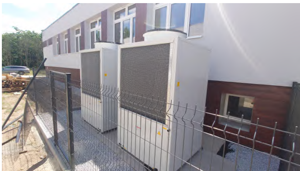
Fot. 3.23. Widok przykładowego montażu kaskady pomp ciepła.
