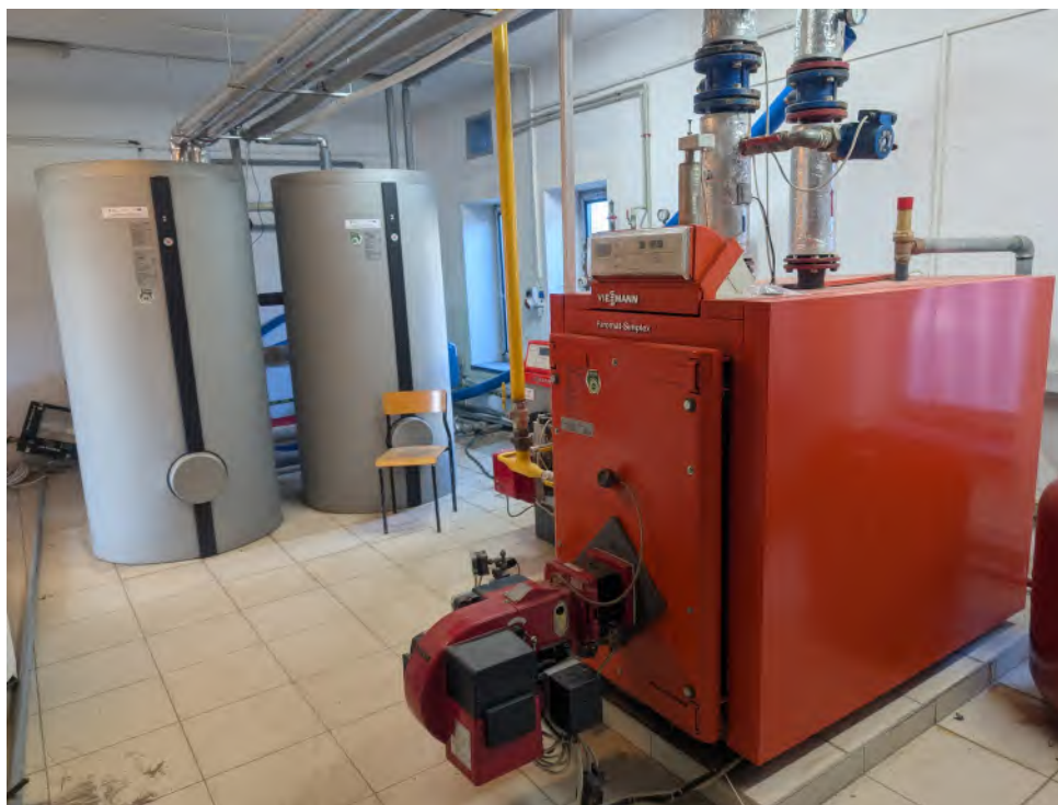
Fot. 3.10. Istniejące źródło ciepła dla budynku hali tenisowej.
