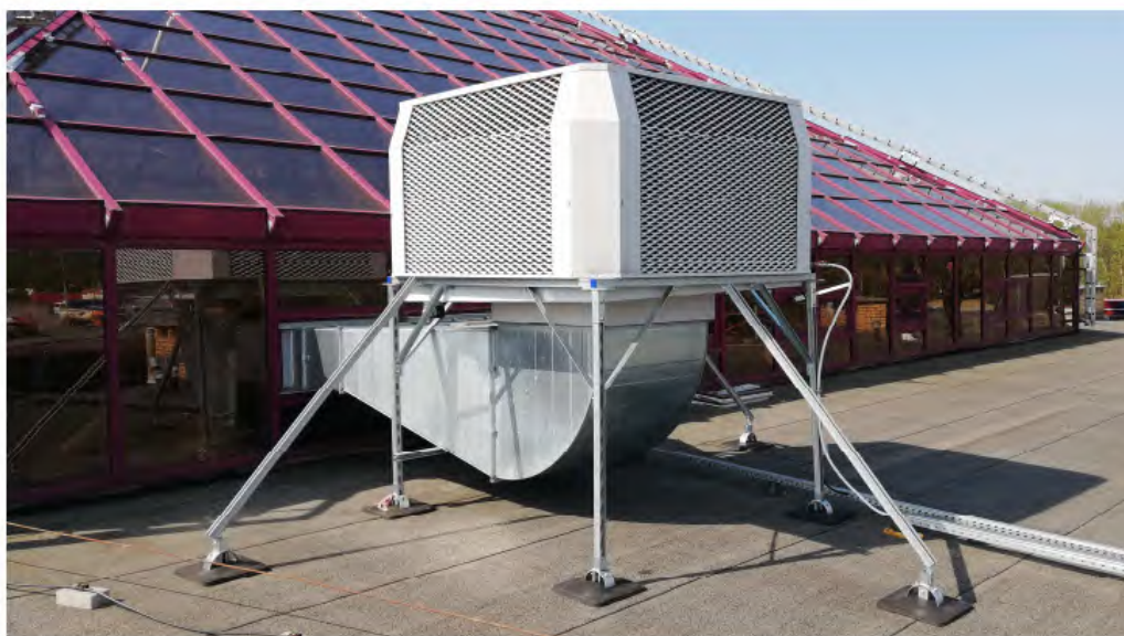
Rys. 3.12. Przykładowy sposób montażu instalacji chłodzenia wyparnego.
