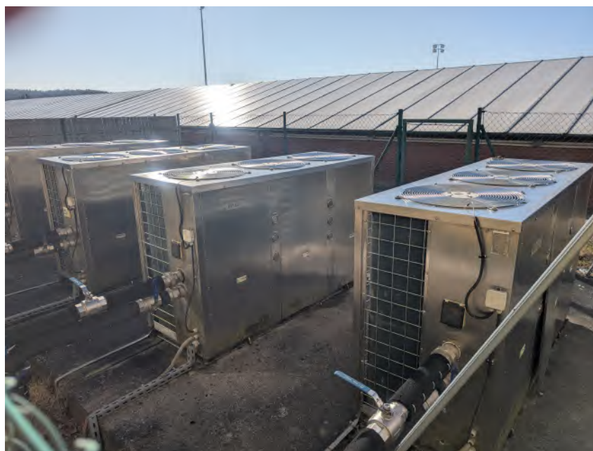
Rys. 3.16. Istniejące pompy ciepła dla kompleksu „Olimpijczyk” przeznaczone do likwidacji.
