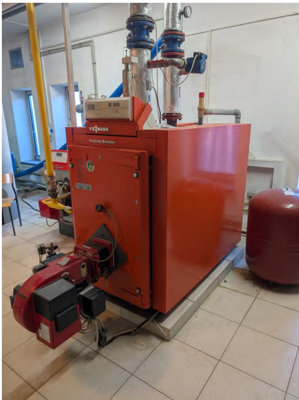
Fot. 3.9. Istniejące źródło ciepła dla budynku hali tenisowej.
