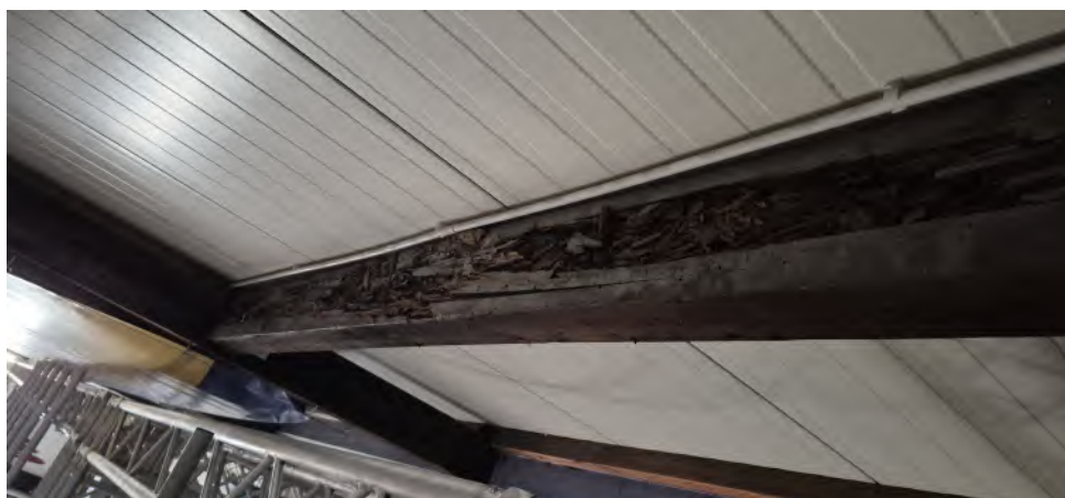
Fot. 3.20. Widok przykładowego fragmentu elewacji frontowej wymagającej naprawy i/lub wymiany.
