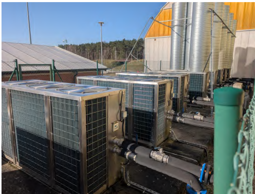
Rys. 3.14. Istniejące pompy ciepła dla kompleksu „Olimpijczyk” przeznaczone do likwidacji.
