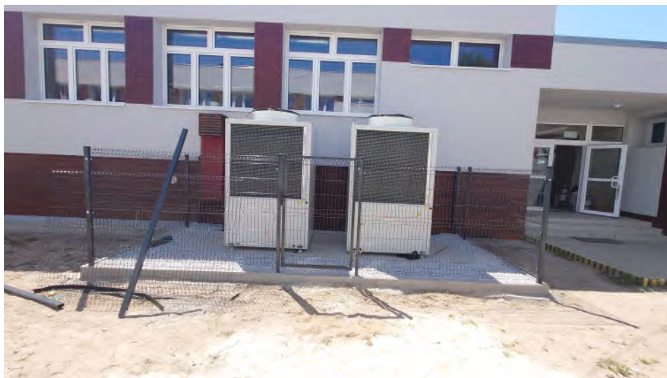
Fot. 3.22. Widok przykładowego montażu kaskady pomp ciepła.
